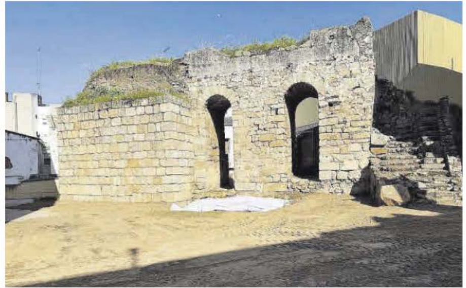
Torre Albarrana en el solar de la calle Arzobispo Mazona.
